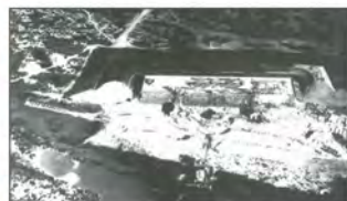
2_Forte Batteria Radaelli, 1909-1914
